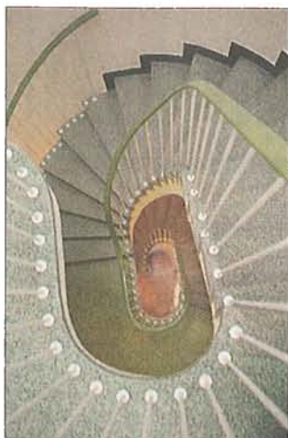
Der Terrazzoboden im Treppenhaus ist eines der erhaltenen Originaldetails des im Krieg stark zerstörten Hauses.
